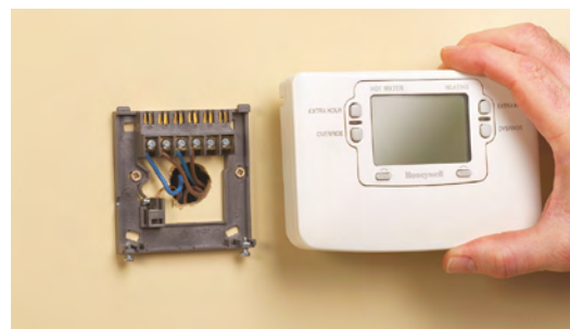
Εγκαταστήστε τον RF2 timer
