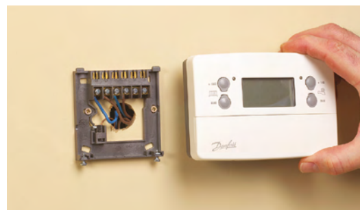
Αφαιρέστε τον παλιό χρονοθερμοστάτη
